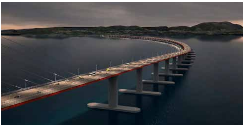
I Norge planerar Statens Vegvesen för en 5 km lång flytbro över Bjørnafjorden, den längsta i sitt slag i världen, där Axel Hörteborn på SSPA varit med och analyserat risken för brokollissioner.
